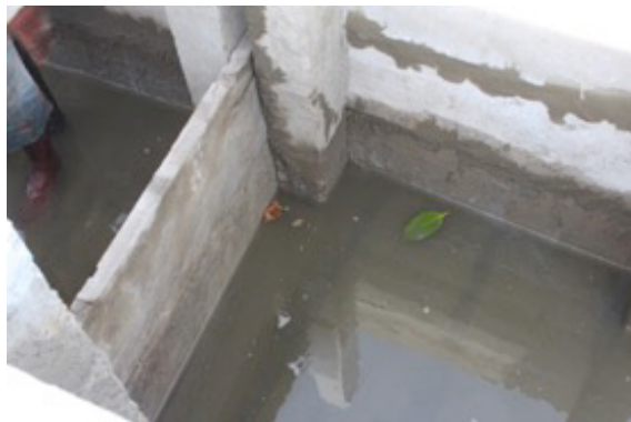
Gambar 6. Proses instalasi pintu air tambak dari beton ringan
