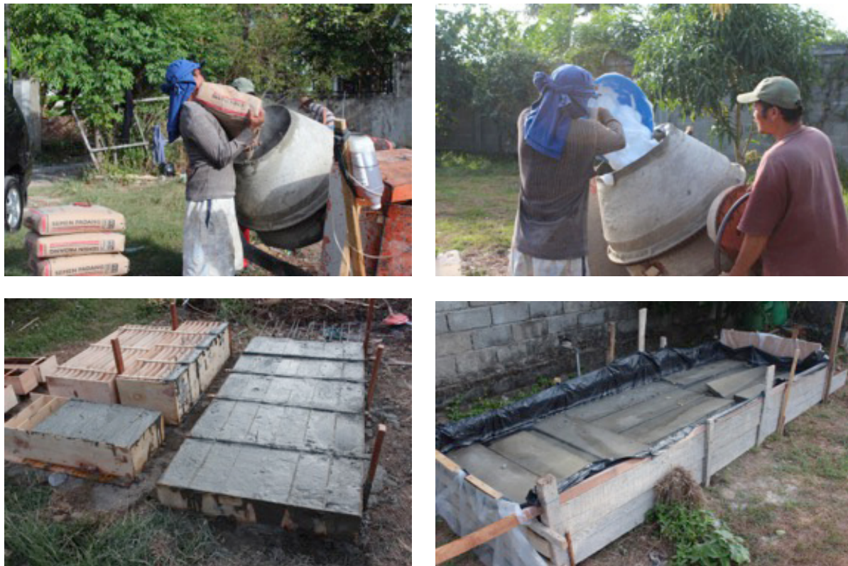
Gambar 5. Proses pembuatan pintu air tambak dari beton ringan
